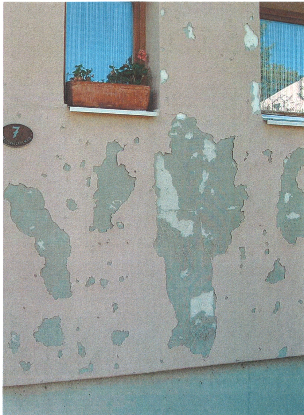
Bild 3: Kein eindeutiger Hagelschaden.
