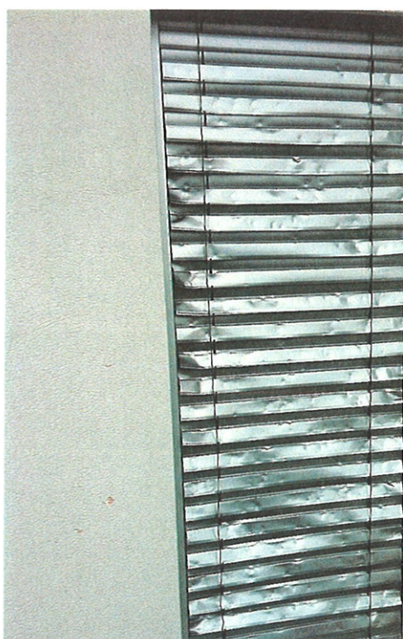
Bild 5: Echter Hagelschaden.
