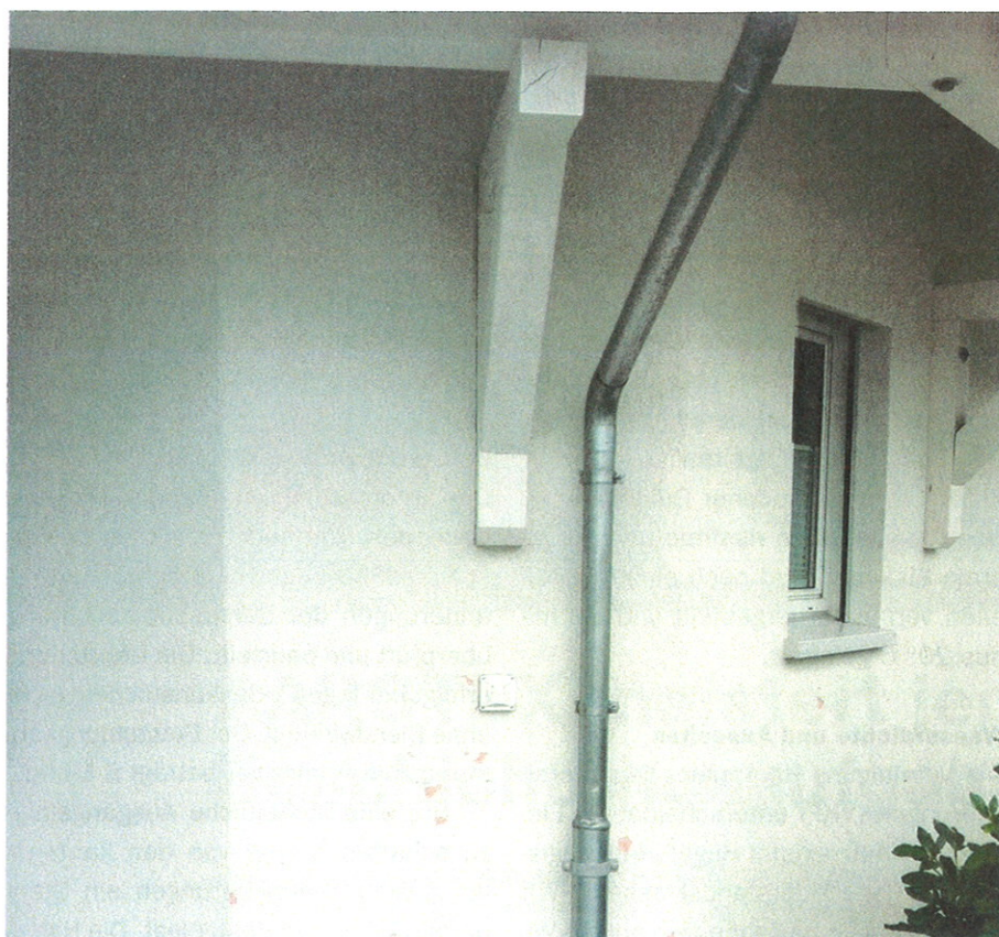
Bild 17: Gut geschützte Fassade.
